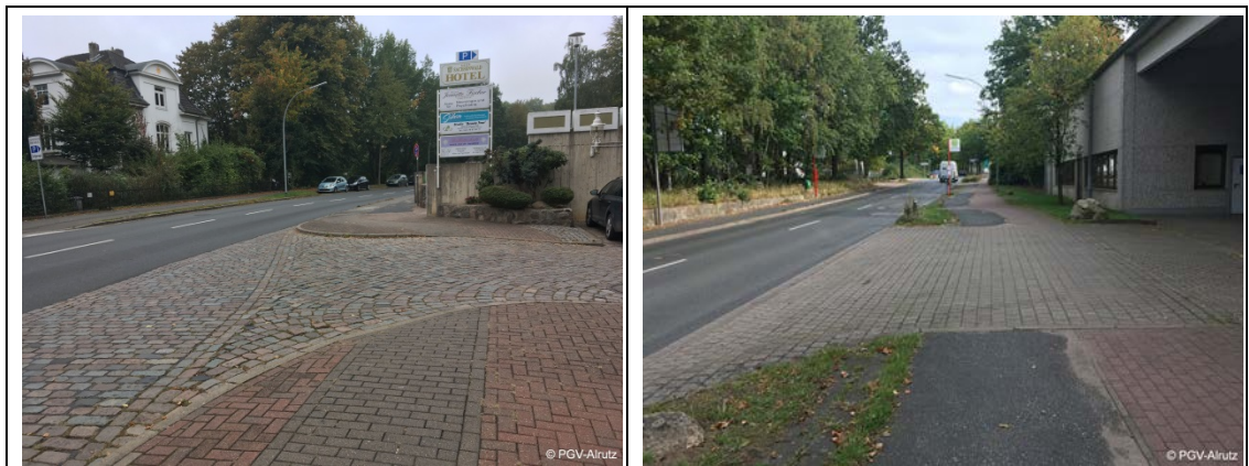
Abb. 3-3: Fehlende Furt und unzureichende Belagsqualität im Zuge der Hamburger Straße (L 223, links), Unterbrechung des Radweges an Grundstückszufahrt im Zuge Hermann-Körner-Straße (rechts)
