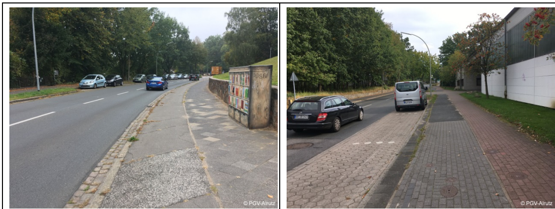
Abb. 3-1: Radwege in unzureichender Breite und schlechter Belagsqualität im der Hamburger Straße (L 223, links) und Hermann-Körner-Straße (rechts)
