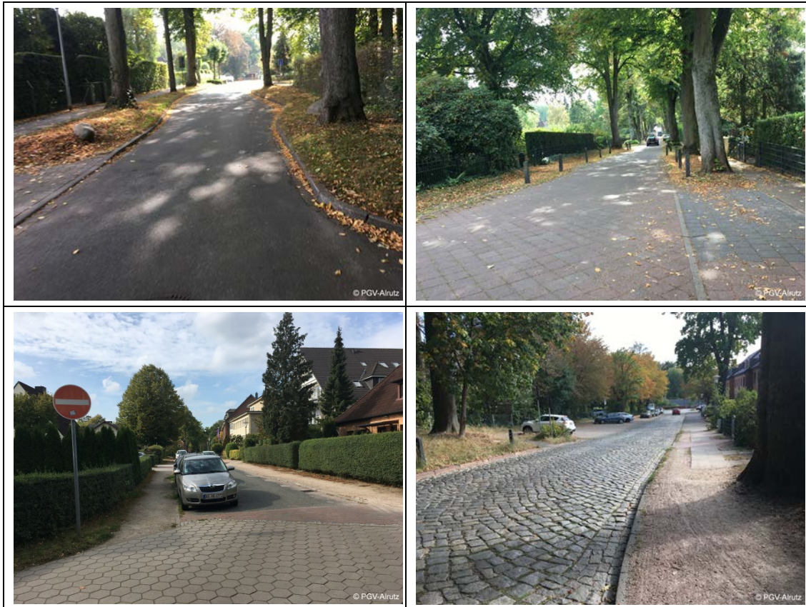
Abb. 3-4: Mischverkehr im Zuge Schillerstraße (oben links) und Kückallee (oben rechts); Lindenstraße ohne Freigabe für Radverkehr in Gegenrichtung und unzureichende Belagsqualität (unten links); Parkallee mit unzureichender Belagsqualität (oben rechts).
